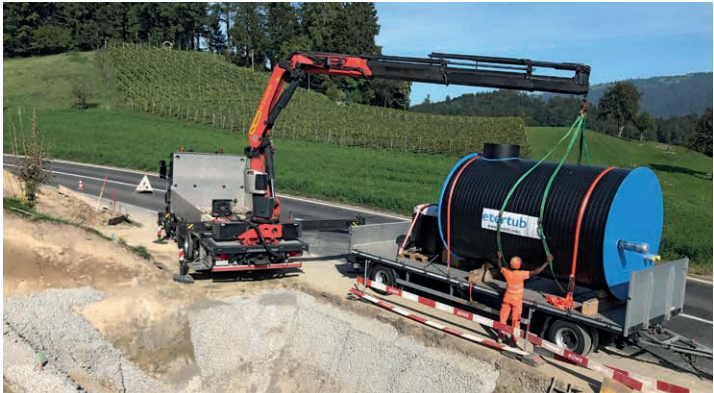
Abladen des Schachtes
