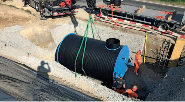
Einbau des Schachtes
