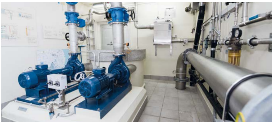
PW Reussschachen (innen)
