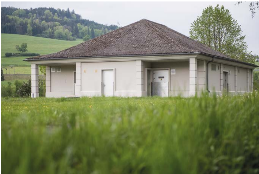
Reservoir Reusschachen (aussen)
