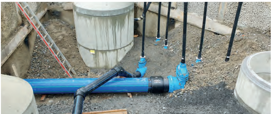
Verlegte Leitungen vor Bauernhof (Poststrasse)
