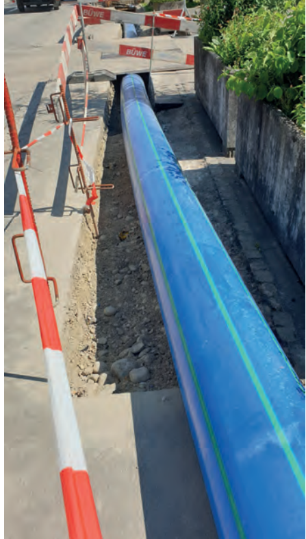
Einzug in bestehende Gussleitung für Leitungsersatz Poststrasse, HDPE Rohr 355 mit Schutzmantel
