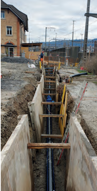
Leitungsbau Verbindungsleitung Binzmühlestrasse–Postplatz
