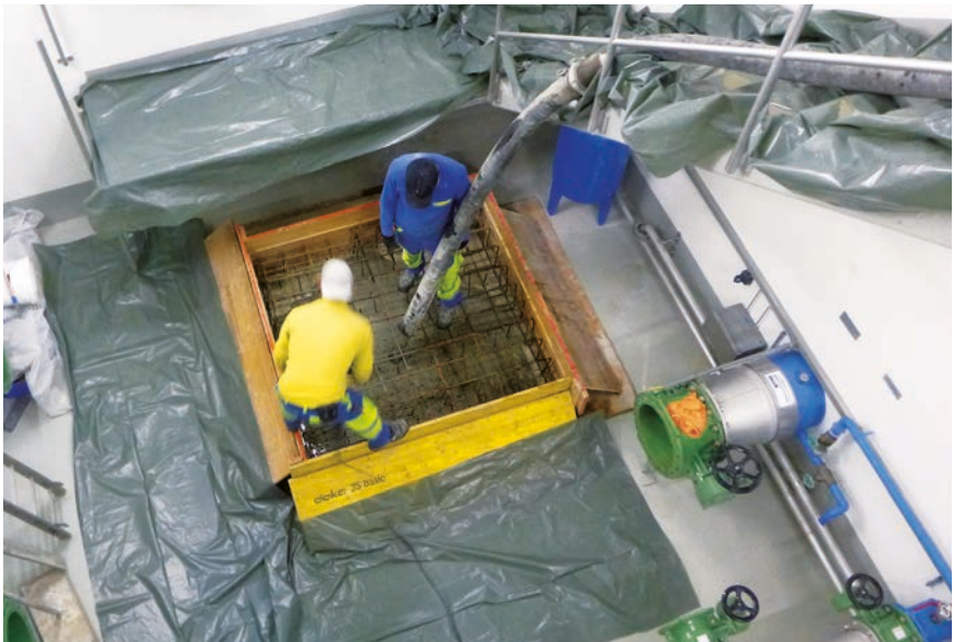
Betonieren neuer Pumpensockel
