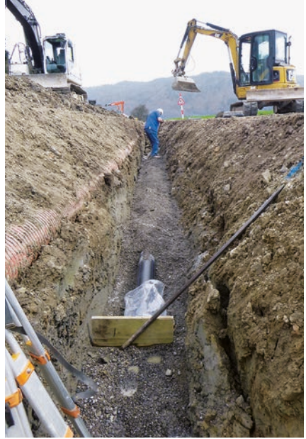
Ausbau Erschliessung Stockeri
