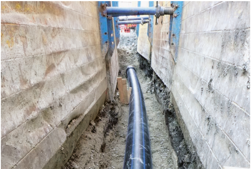
Hauptleitung Ø 200 mm Suurstoffi Baufeld 1
