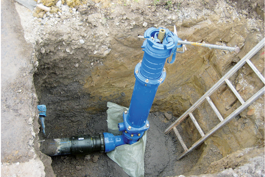
Ibikon Hydrantenunterteil
